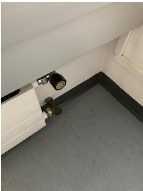
Non è presente nessuna regolazione d'ambiente automatica: vi è solo una regolazione manuale mediante rubinetto.
